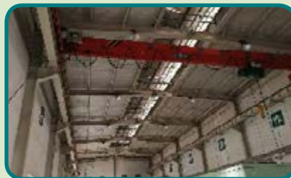
廠房LED燈改造
