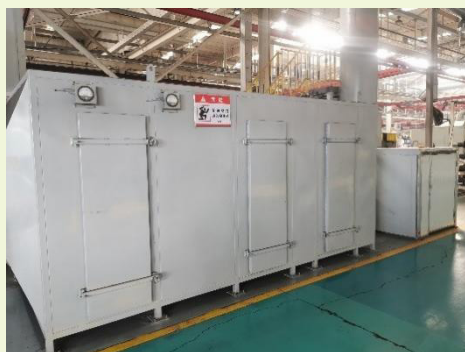
▲ 橋殼防銹工序廢氣收集裝置
