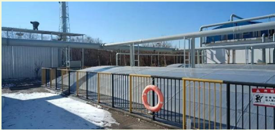
▲ 污水處理站污水池廢氣收集裝置
