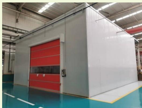
▲ 橋殼防銹工序廢氣收集裝置
