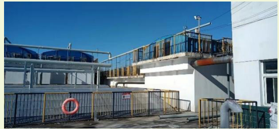
▲ 污水處理站污水池廢氣收集裝置
