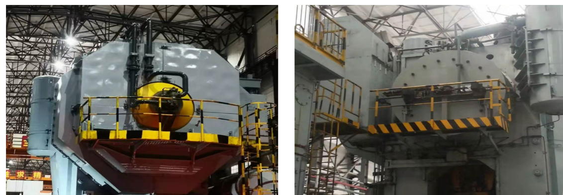
濟南成型廠消音系統自主改造項目
